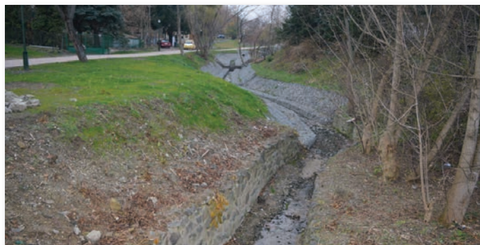
A felújított Mélyárok a Rákóczi utca felől
